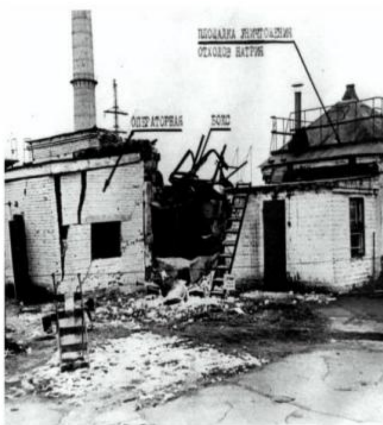
Рисунок 4.2 – Разрушения, вызванные взрывом водорода при проведении отмывки ХЛО от остатков натрия парогазовой смесью
