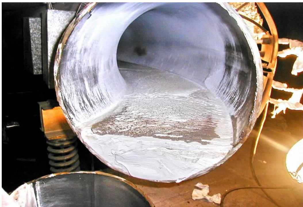
Рисунок 4.1 – Элемент трубопровода БН-350 с остатками натриевого теплоносителя [37]
